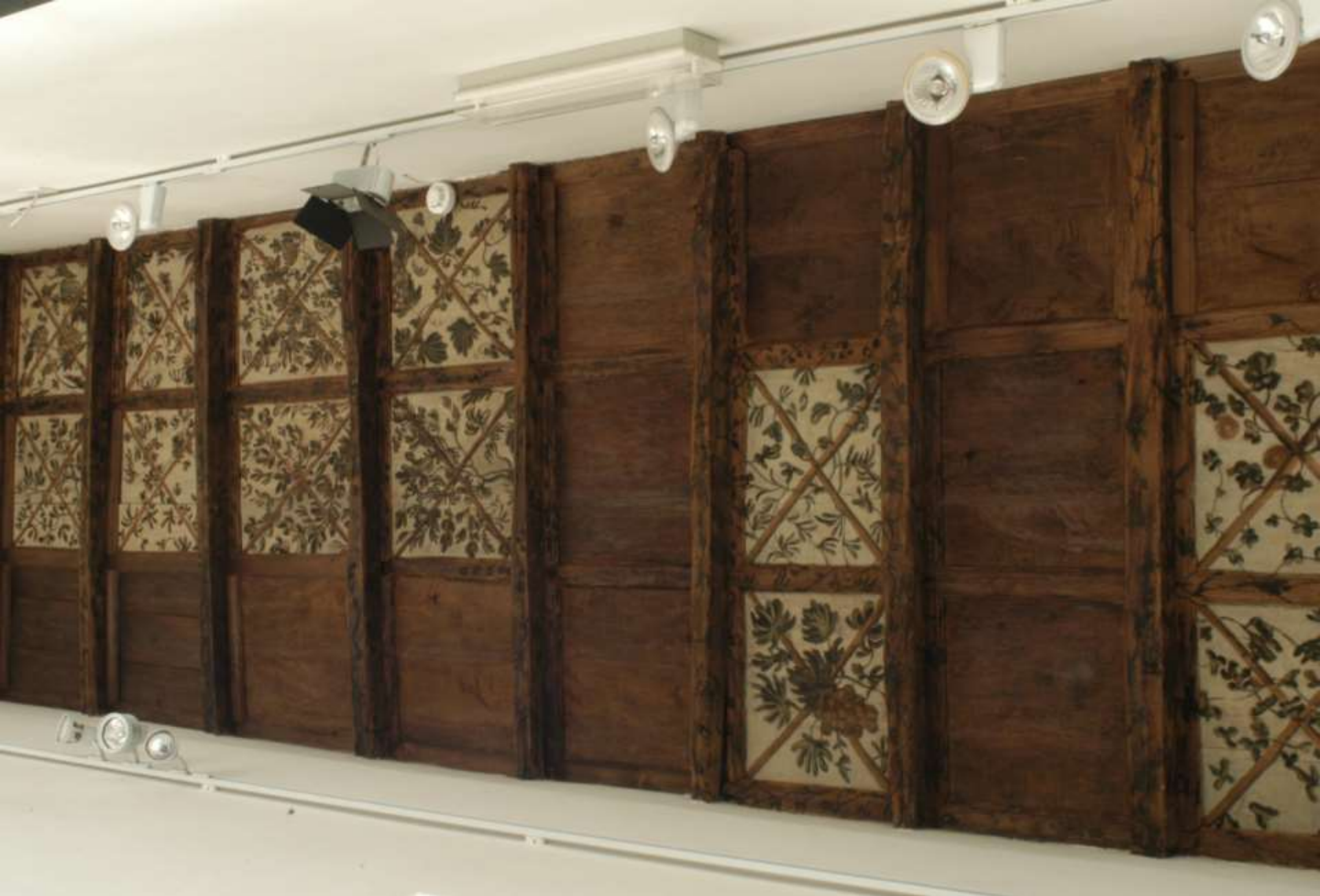
La Villa vecchia particolare del soffitto
